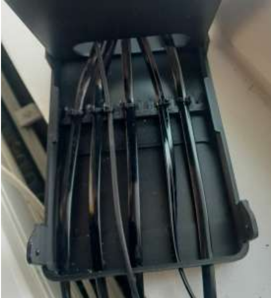
Kuva: Kaapeleiden kiinnitys.
