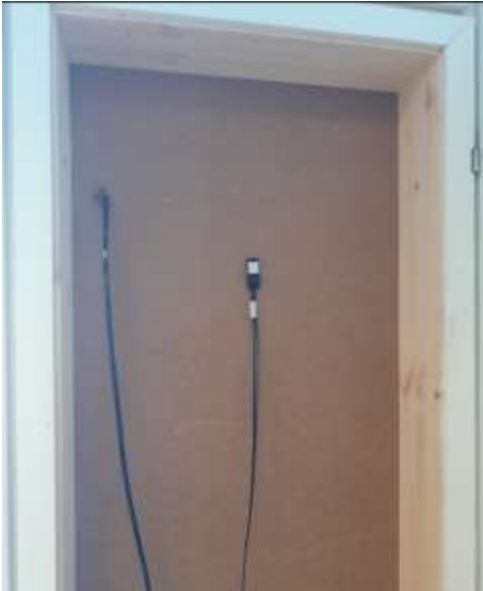
Kuva: Anturi 2. asennettuna tuulensuojalevyyn kiinni.
